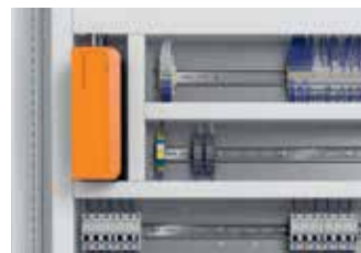
Industrie-PC von B&R ohne mechanische Verschleißteile
