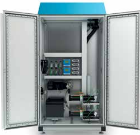
Der Maschinenschrank ist in den Zellenkorpus integriert und beinhaltet die Dosierperipherie.
