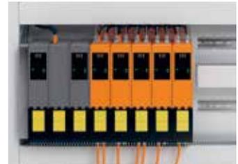
Neue Servotechnik für die Dosierzelle SMART - M mit integrierter Sicherheitslogik und zentrale Leistungsversorgung
