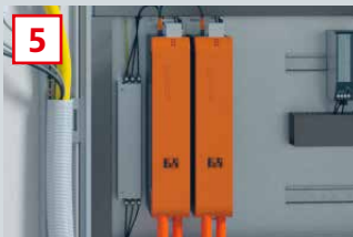
5 Servotechnik mit integrierter Sicherheits- logik und zentraler Leistungsversorgung
