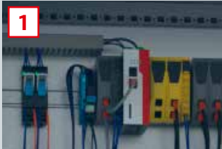
1 VPN Router zur Fernwartung (Remote Collaboration)
