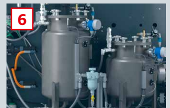
Materialdruckbehälter mit optimierten Größen für asymmetrische Mischungsverhältnisse
