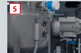
Kapazitive Sensoren für die Füllstandsregulierung
